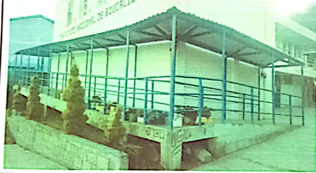
Foto 1: Sustitucion y bajadas de agua
