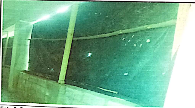
Foto 5: Sustitucion de ventana por metal con vidrio
